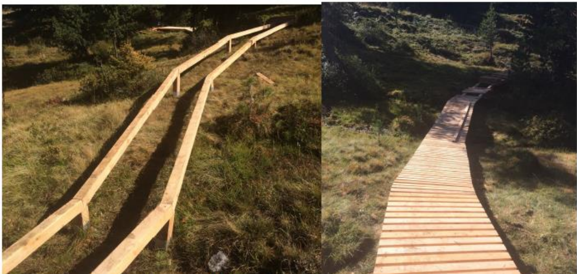
Abb. 37: Bauvorbild für aufgeständerte Querung Feuchtflächen
