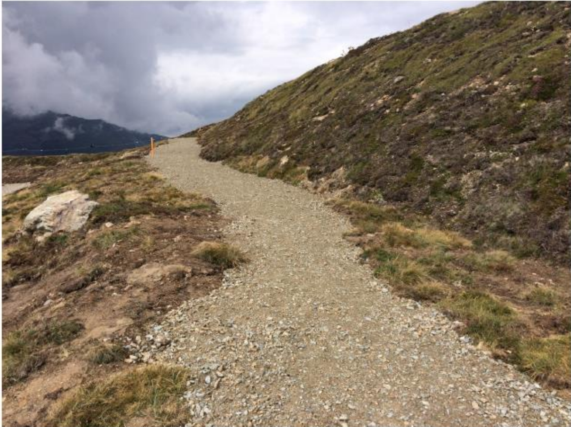
Abb. 35: Bauvorbild für geschotterten, kinderwagentauglichen Weg; Böschungen mit Vegetationsstücken rekultiviert.
